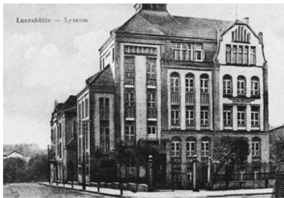
Budynek I Liceum Ogólnokształcącego im. Jana Śniadeckiego w Siemianowicach na starej pocztówce
